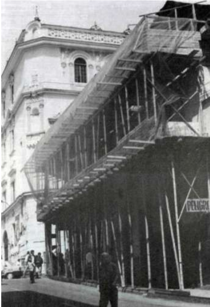
Cierre exterior Foto. JCGL
