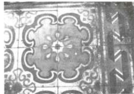
Piso baldosa cemento a proteger. Foto JCGL
