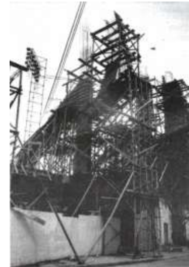
Andamio en construcción. Estructura Estadio Palogrande. Foto JCGL
