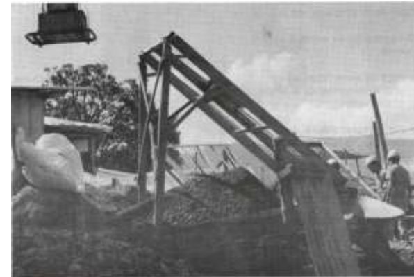
Elaboración de estructuras de protección de materiales. Foto. JCGL
