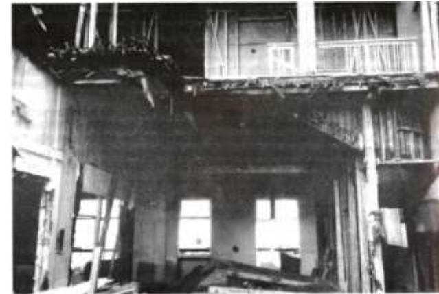
Proceso de demolición de un inmueble en el centro de Manizales. Foto JCGL
