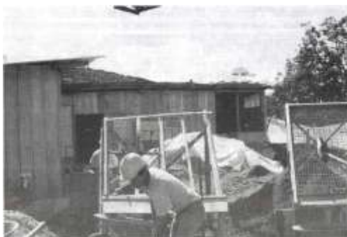
Construcción y adecuación de espacio para bodega de materiales. Foto. JCGL
