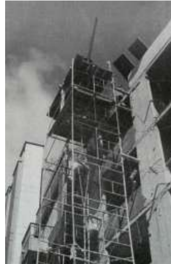
Andamio metálico usado en exteriores. Foto JCGL
