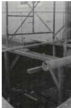
Nivelación de estructura de piso para instalación de andamio metálico
