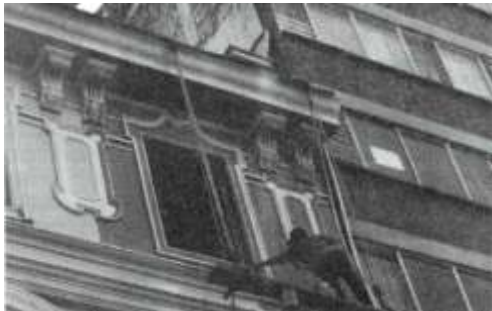
Andamio volante. Foto JCGL
