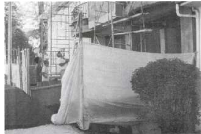
Armado de un andamio. Foto JCGL
