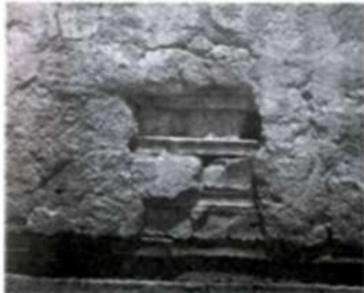
IMAGEN 15. MURO EN BAHAREQUE EMBUTIDO
