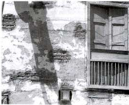
IMAGEN 14. MURO EN BAHAREQUE EMBUTIDO VISTA
