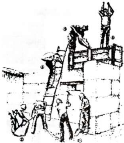
FIGURA12 PROCESO EN LA CONSTRUCCION DEL MURO
