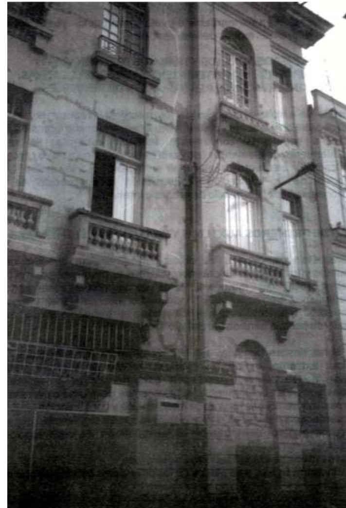
Primera aproximación al inmueble. Foto JCGL
