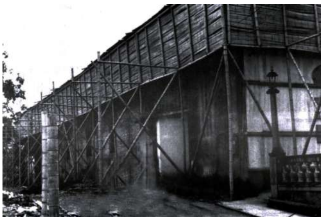
Ejemplos de apuntalamiento exterior. Foto. JCGL
