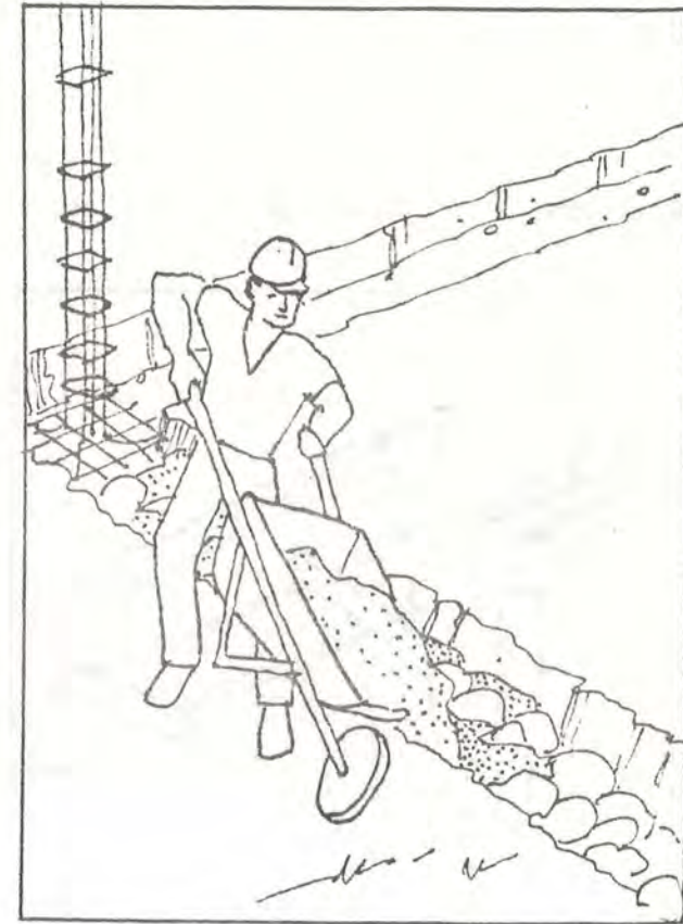
Vacía y vibre capa de hormigón
