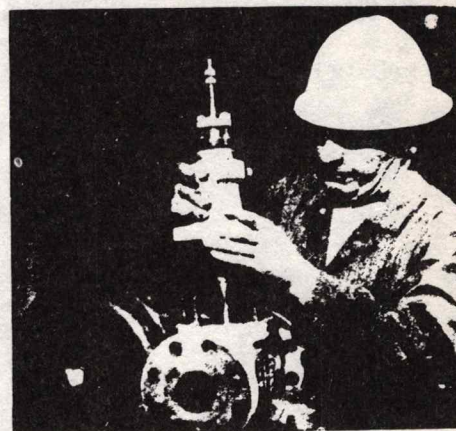
El conjunto del obturador consiste del vástago y el obturador.
