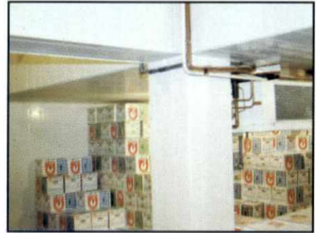
Diap. C.F. 1.2 Disposición del evaporador en un cuarto grande
