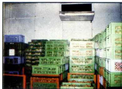
Diap. C.F. 4.10 El espacio libre superior y entre empaques, facilita la recirculación del aire
