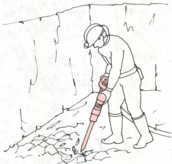
ARRANQUE MINERAL DEL PISO
