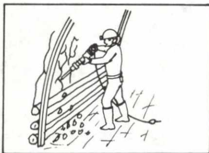
4º PARA AMPLIAR SECTORES DE LAS PAREDES Y TECHOS
